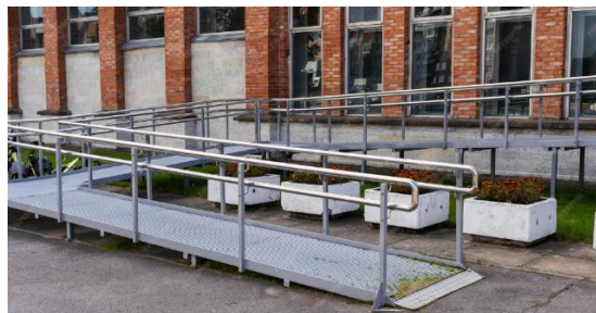
Exemple d'accès en rampe
